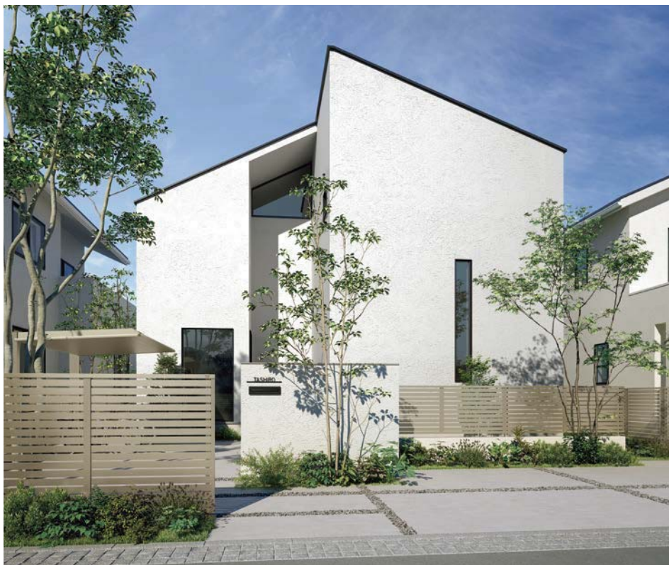
フェンス:YS2型 T-12(道路側)・T-8(家側) シャイングレー 駐輪場:カーポートSCミニ シャイングレーF
